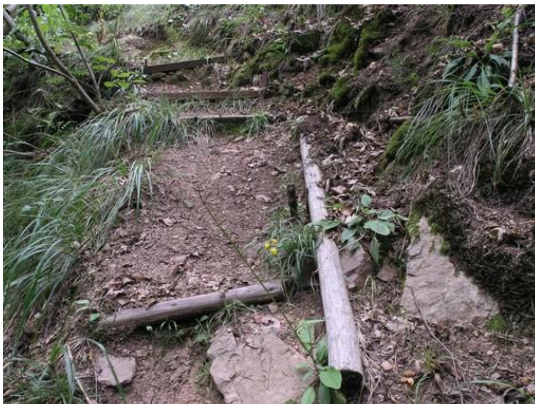
obr.14 – provizorní zpevnění stezky ke spodní chatě
