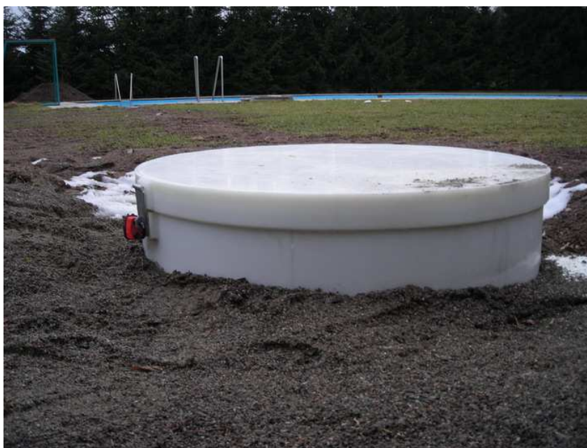
Obr.č.1 Nová vrtaná studna u koupaliště
