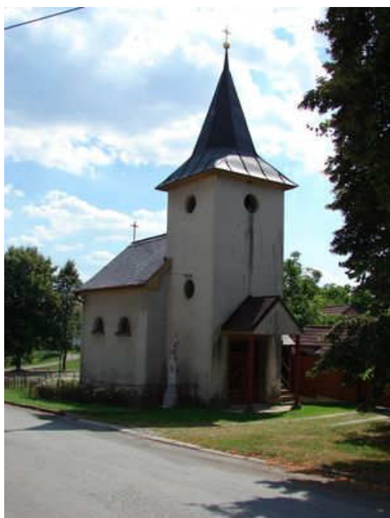
Obr.č.1 - Kaple před rekonstrukcí
