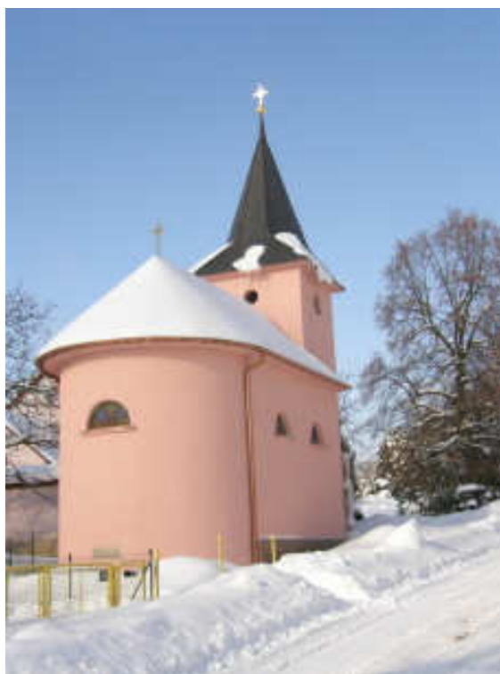
Obr.č.2 - Kaple po rekonstrukci
